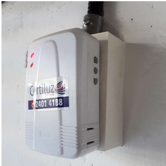
CONTROL MANUL DE CORTINAS METÁLICAS
