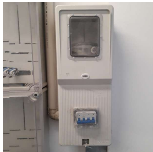
CONTADOR DE BOMBA DE INCENDIO
