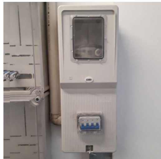
CONTADOR DE BOMBA DE INCENDIO
