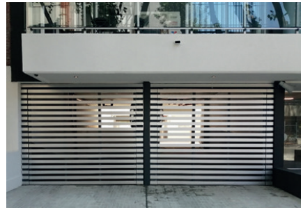
PORTÓN BASCULATE ACCESO A COCHERAS SUBSUELO Y PLANTA BAJA
