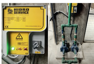
TANQUES INFERIORES - BOMBA DE IMPULSIÓN – COMANDO
