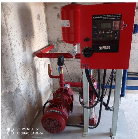
BOMBA DE INCENDIO NIVEL 11 – TANQUES DE AGUA GARAJE Y BOMBAS IMPULSION
