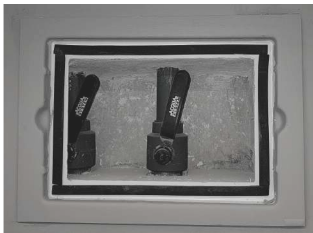
TAPA REGISTRO DE LLPP GENERALES ACCESO A CADA UNIDAD - ABASTECIMIENTO AGUA FRÍA + AGUA PRECALENTAMIENTO
