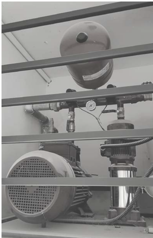
BOMBA DE INCENDIO HIDRONEUMÁTICA + TABLERO DE BOMBA
