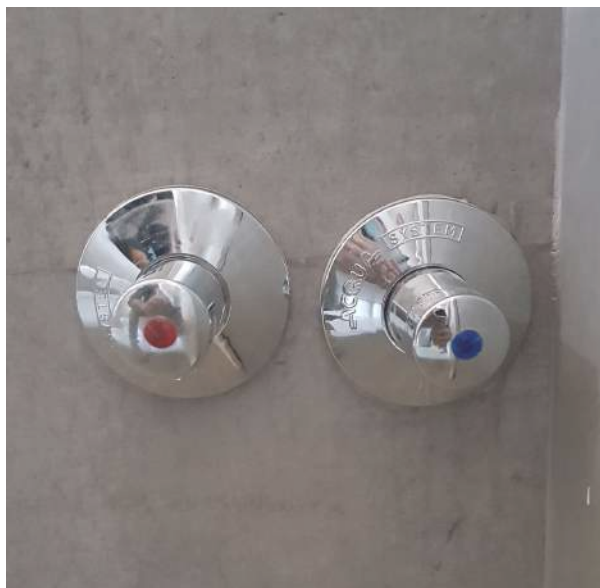
LLPP BAÑOS (UBICADAS DEBAJO DEL MUEBLE) - ABASTECIMIENTO AGUA FRÍA + AGUA CALIENTE (DE CALEFÓN)
