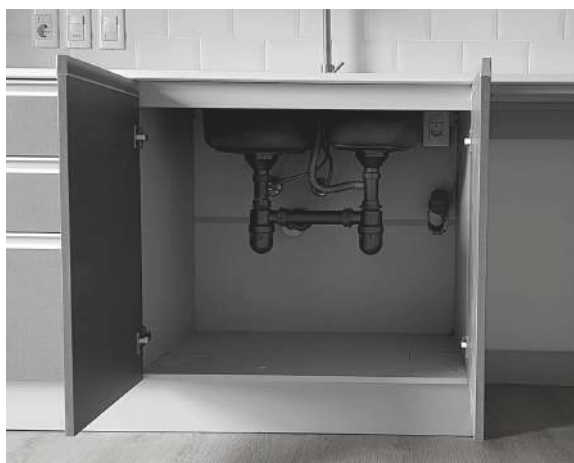
LLPP COCINAS (UBICADAS EN COLILLAS) - ABASTECIMIENTO AGUA FRÍA + AGUA CALIENTE (DE CALEFÓN)
