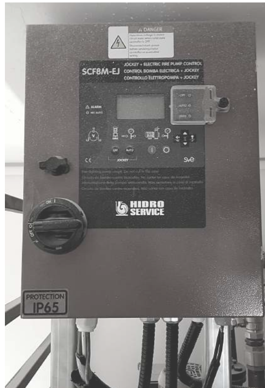
BOMBA DE INCENDIO HIDRONEUMÁTICA + TABLERO DE BOMBA
