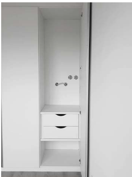
LLPP CALEFÓN (UBICADAS DENTRO MUEBLE DORMITORIO) - ABASTECIMIENTO AGUA FRÍA (ENTRADA) + AGUA CALIENTE (SALIDA)
