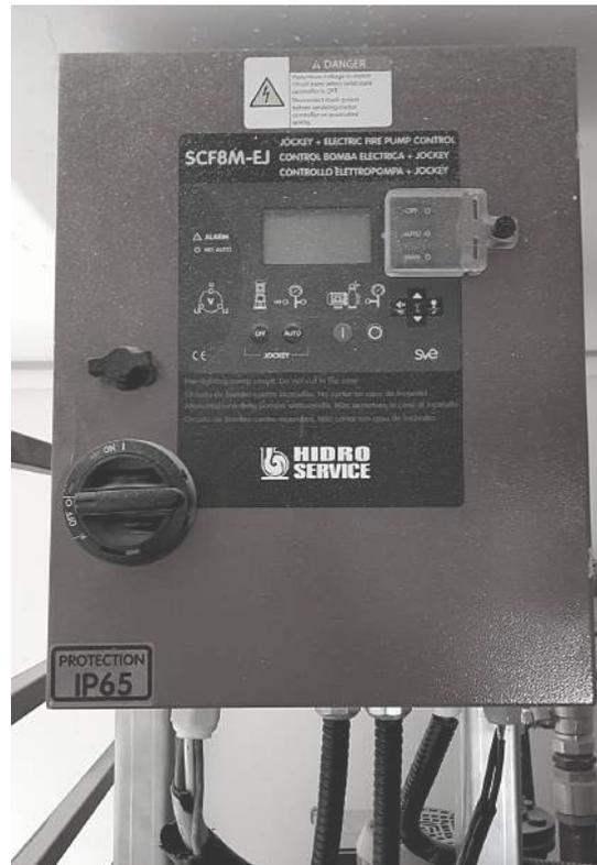
BOMBA DE INCENDIO HIDRONEUMÁTICA + TABLERO DE BOMBA
