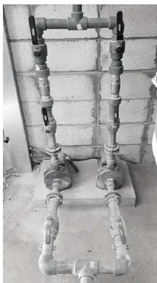
TANQUE INFERIOR + SISTEMA DE BOMBAS DE IMPULSIÓN + TABLERO DE BOMBAS (UBICACIÓN PLANTA BAJA)
