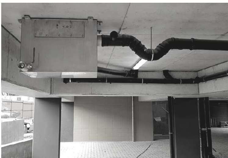
GRASERA COLECTIVA SUSPENDIDA (UBICACIÓN PLANTA BAJA)
