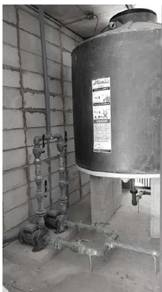
TANQUE INFERIOR + SISTEMA DE BOMBAS DE IMPULSIÓN + TABLERO DE BOMBAS (UBICACIÓN PLANTA BAJA)
