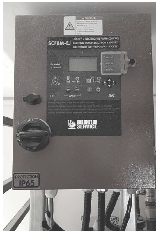
BOMBA DE INCENDIO HIDRONEUMÁTICA + TABLERO DE BOMBA
