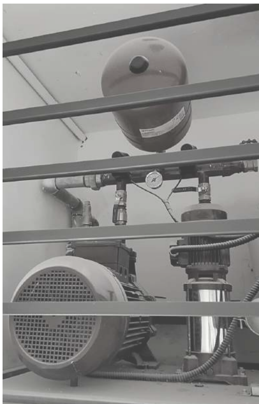
BOMBA DE INCENDIO HIDRONEUMÁTICA + TABLERO DE BOMBA
