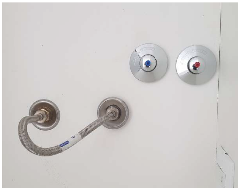
LLPP CALEFÓN (UBICADAS DENTRO MUEBLE DORMITORIO) - ABASTECIMIENTO AGUA FRÍA (ENTRADA) + AGUA CALIENTE (SALIDA)
